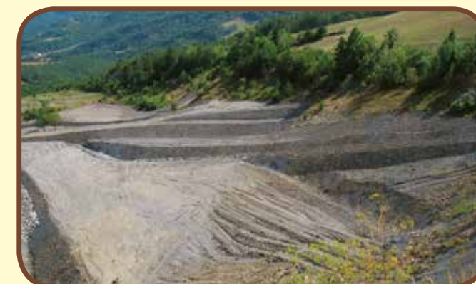
Messa in sicurezza di pendici franose
