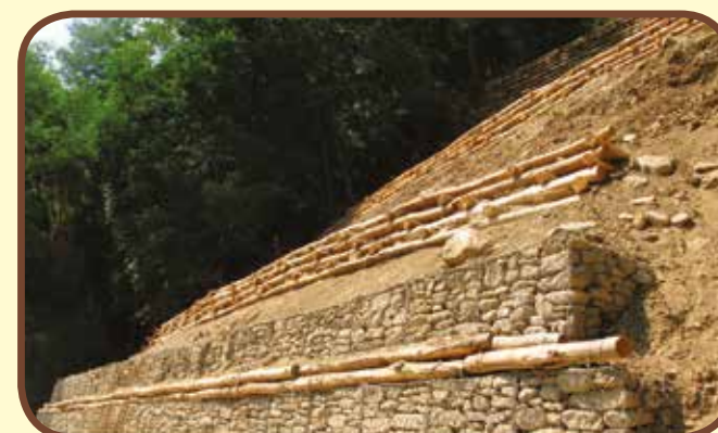
Consolidamento di scarpata in frana
