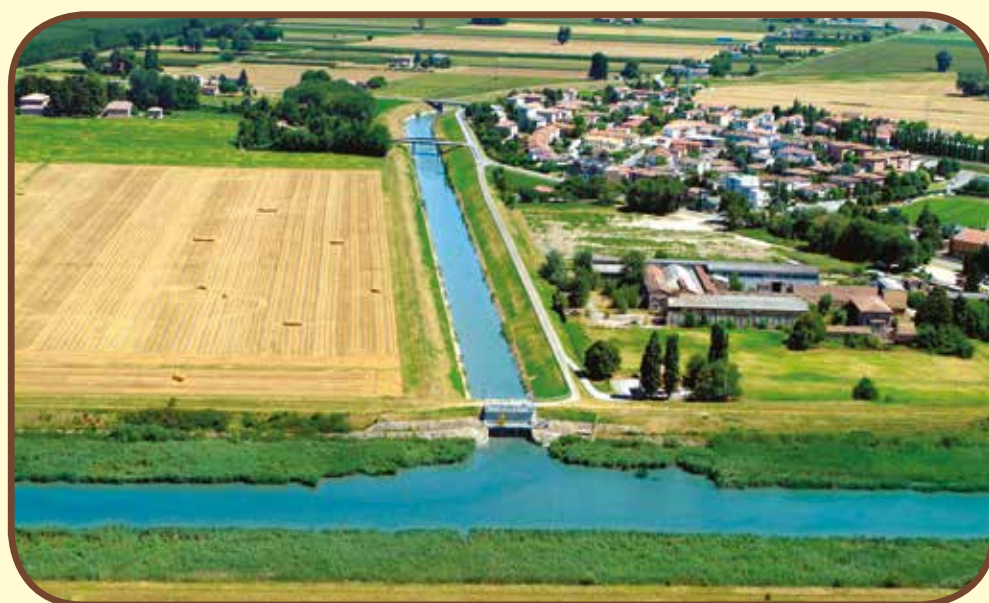
Il Canale Emiliano Romagnolo (CER), struttura artificiale che porta le acque dal fiume Po, in tutta la pianura fino a Rimini: è questa la fonte principale dell'acqua di superficie impiegata per l'irrigazione
