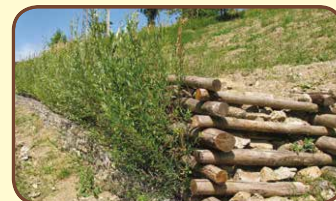
Stabilizzazione di versante franoso
